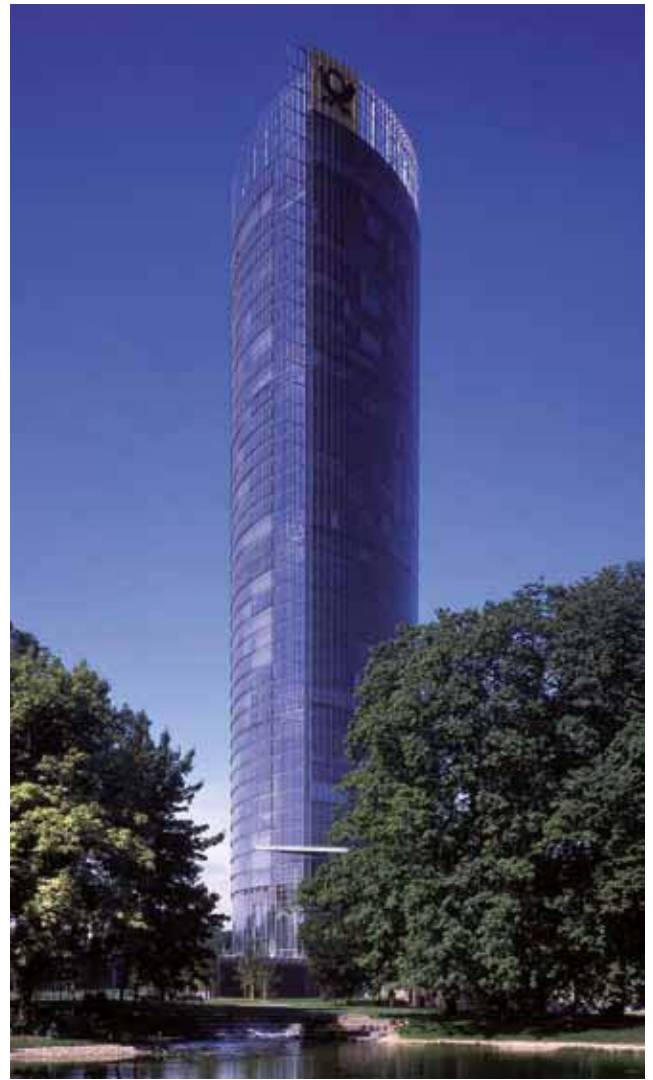
Post Tower der Deutsche Post AG.
